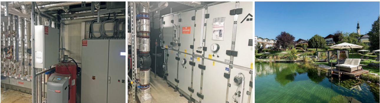
Regelung und RLT-Anlage für den Hang-Spa.
