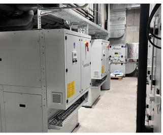
Detailansicht der energieeffizienten Fassade aus Betonfertigteilen, ergänzt durch hochmoderne Sonnenschutzgläser, die sowohl ästhetisch ansprechend als auch funktionell im Energiekonzept der Jäger Bau Firmenzentrale sind. Die reversiblen Hochtemperatur-Wärmepumpen von bösch, mit einer Leistung von ie 103 kW, werden mit dem Kältemittel R513A betrieben.
