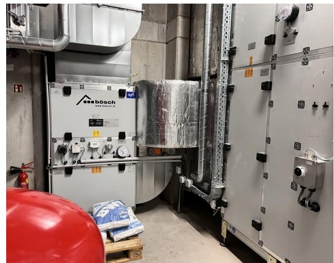
Das RLT-Gerät für die Klimatisierung der Büroflächen fördert in der Stunde 20.000 m<sup>3</sup> perfekt aufbereitete Raumluft. Komplett im Werk gefertigt: das Abluft-Gerät für die Tiefgarage mit einer Luftleistung von 4.500 m<sup>3</sup>/h.
