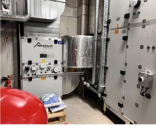
Das RLT-Gerät für die Klimatisierung der Büroflächen fördert in der Stunde 20.000 m³ perfekt aufbereitete Raumluft. Komplett im Werk gefertigt: das Abluft-Gerät für die Tiefgarage mit einer Luftleistung von 4.500 m³/h.
