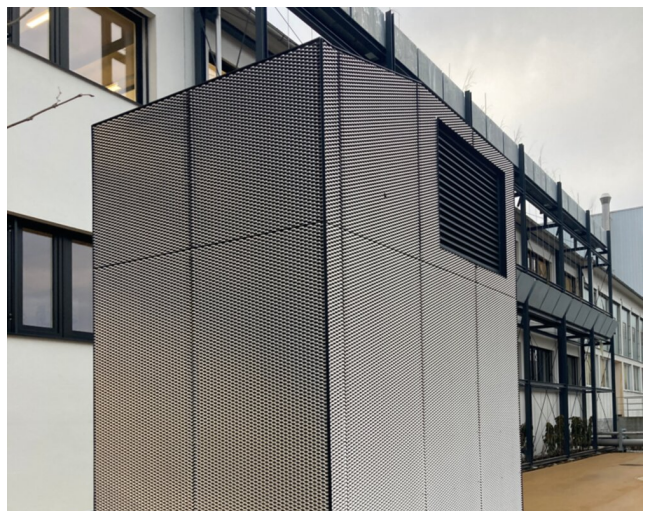
Im Außenluft-Fortluft-Turm wird die Luft bereits gefiltert, bevor sie durch das Kanalnetz strömt. Der Außenluft-Fortluft-Turm: Eine Sonderkonstruktion speziell entwickelt, die individuellen Kundenanforderungen zu erfüllen.
