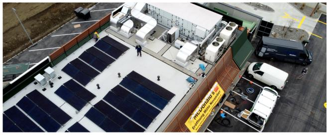
Die Gebäudetechnik (bösch All-in-one Kompaktlüftungsgerät, Wärmepumpen Clivet WSAN-YES und ein Samsung Klimagerät) sind auf dem Dach des Gebäudes positioniert.
