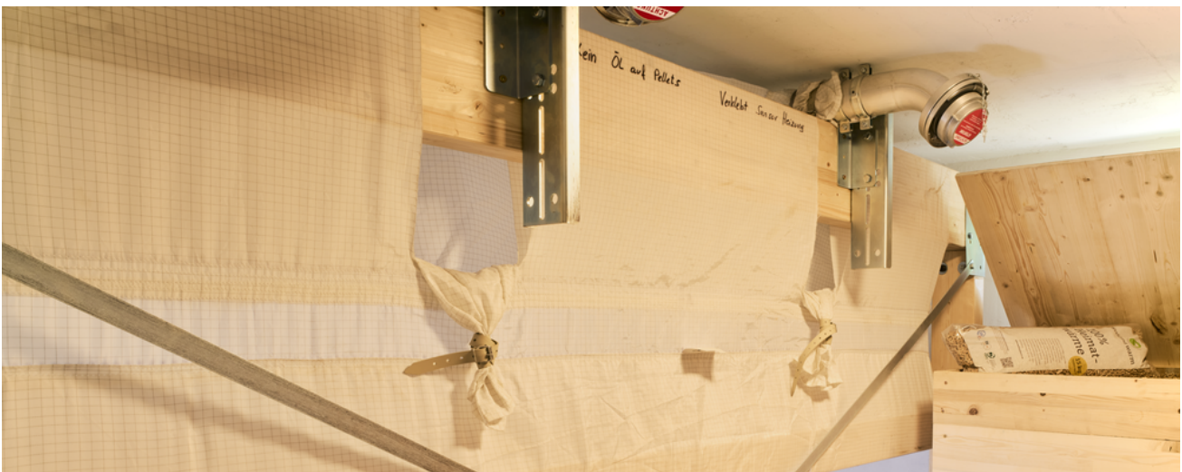
Im ehemaligen Öl-Tankraum ist der 6,5 t fassende Sacksilo für die Pellets untergebracht.
