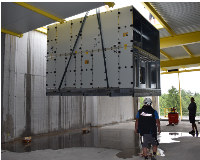
Linkes Bild: Gleich ist es geschafft und das Gerät ist heio durch die Decke. Rechtes Bild: Nach dem Verhub werden die Kuben an die richtige Position transportiert und montiert.
