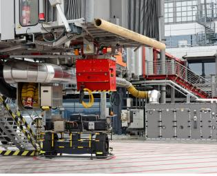
Bis zu 11.000 Pa Gesamtdruck müssen überwunden werden. Hierzu wird eine entsprechende Druckkammer benötigt, die in die Geräte integriert ist. Bei jeder Fluggastbrücke ist ein entsprechendes Lüftungsgerät fix installiert. Die Geräte wurden in den Kategorien D und E ausgeliefert.
