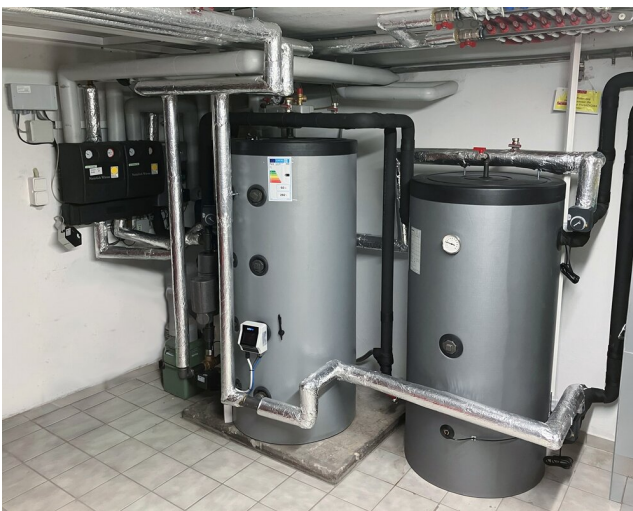
Blick in den Heizraum: Pufferspeicher und Hydraulik der modernisierten Heizungsanlage. Der Wärmepumpenmanager steuert Heizung, Warmwasser und Kühlfunktion der Anlage.
