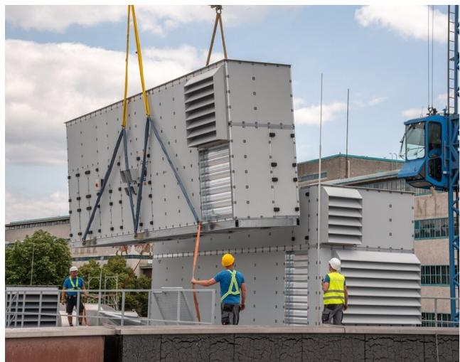
Via Sondertransport wurden die beiden Kuben von Lustenau/Vorarlberg nach Linz transportiert. Am Aufstellungsor: Der erste Kubus ist bereits an Ort und Stelle - der zweite Teil wird passgenau via Kran positioniert und dann vom bösch Montageteam installiert.
