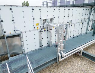
Die neue adiabate Kühlung am Dach von Kansai Helios
