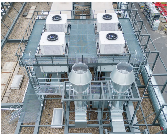
Adiabate Kühleinheiten aus der Vogelperspektive
