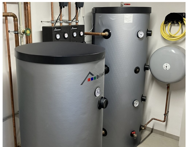
Linkes Bild: Im Heizraum: die komplette bösch Systemlösung mit Hydrobox, Pufferspeicher, Warmwasserspeicher und handgelöteten Kupferrohren. Rechtes Bild: Puffer- und Warmwasserspeicher von bösch garantieren Komfort und zuverlässige Versorgung
